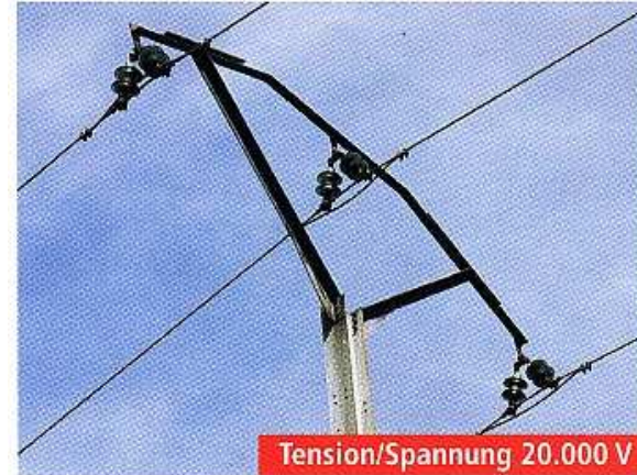
❷ Alignement 2 isolateurs Tragmast 2 Isolatoren
