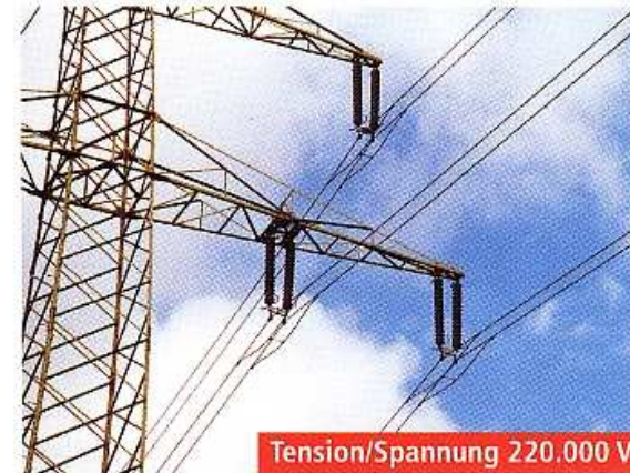
❸ Alignement 16 isolateurs Tragmast 16 Isolatoren
