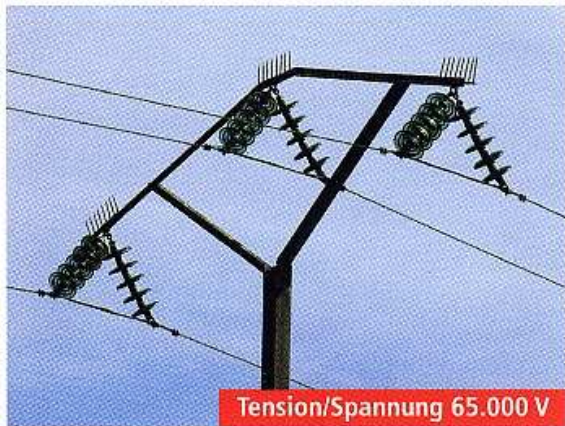
❸ Alignement 5 à 7 isolateurs Tragmast 5 bis 7 Isolatoren
