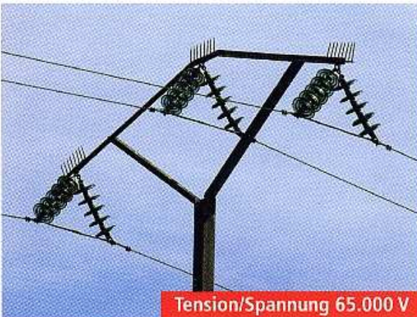
❸ Alignement 5 à 7 isolateurs Tragmast 5 bis 7 Isolatoren
