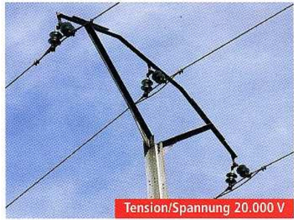
❷ Alignement 2 isolateurs Tragmast 2 Isolatoren
