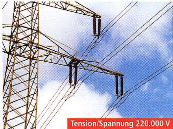
❸ Alignement 16 isolateurs Tragmast 16 Isolatoren
