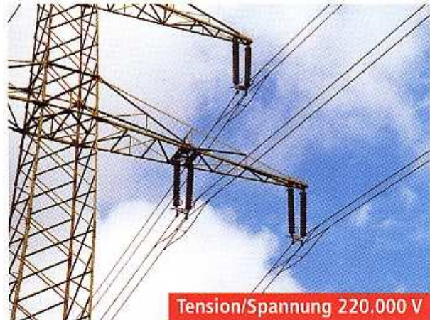
❸ Alignement 16 isolateurs Tragmast 16 Isolatoren
