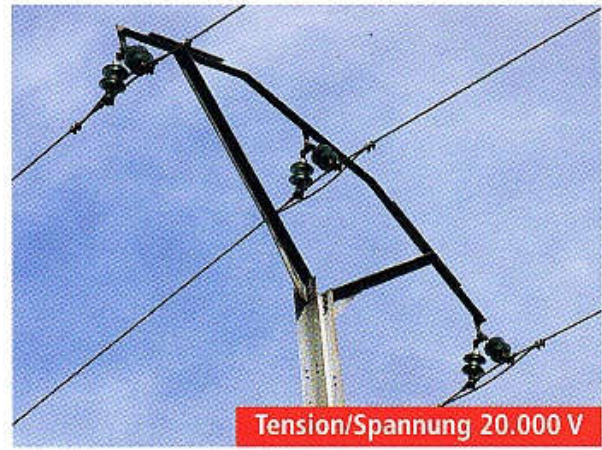
❷ Alignement 2 isolateurs Tragmast 2 Isolatoren
